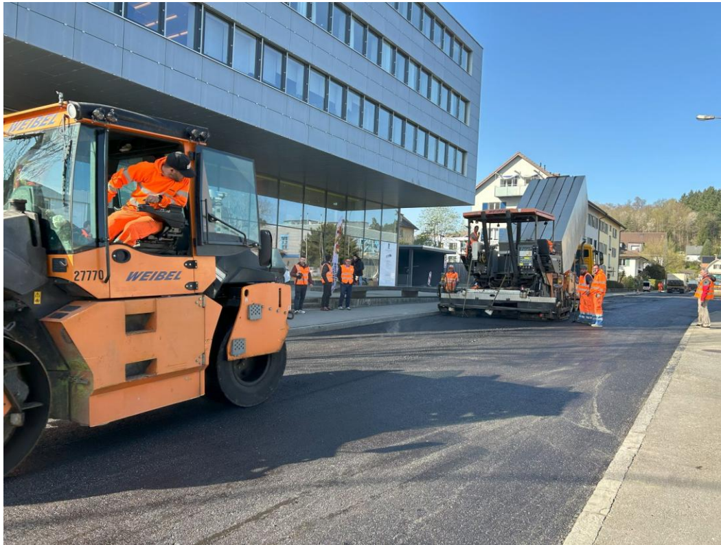
Einbau Binderschicht AC B 22 S Bio in der Waldeggstrasse.
